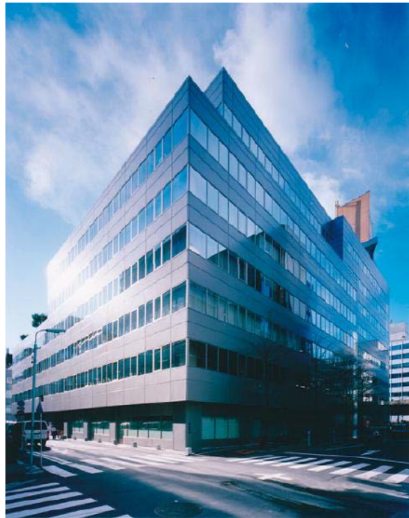
<新日本橋事務所が入居する野村不動産日本橋本町ビルの外観>
