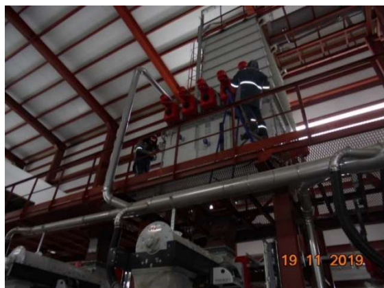
機器の設置工事（主要生産設備）
