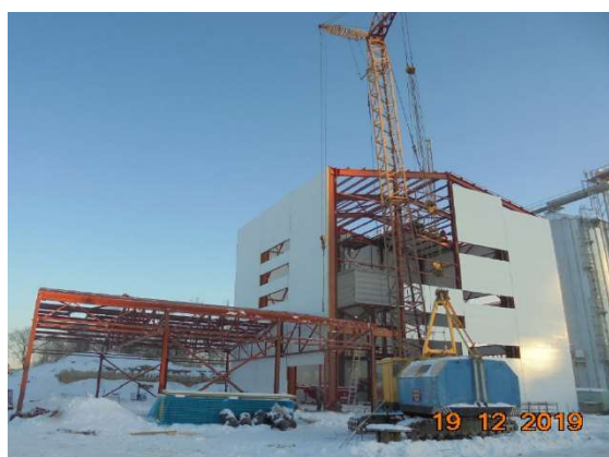
設備の建設工事 （木質ペレット貯蔵庫・サイロ）
