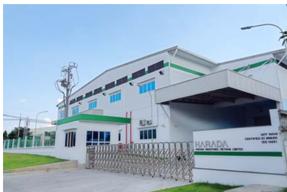
第3工場 外観①
